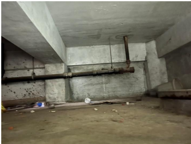
地下室-現況照片
