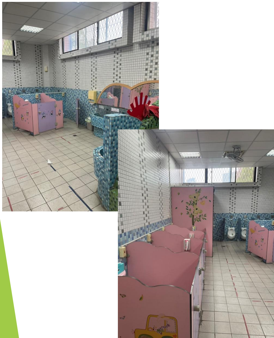
1樓幼兒廁所-現況照片
